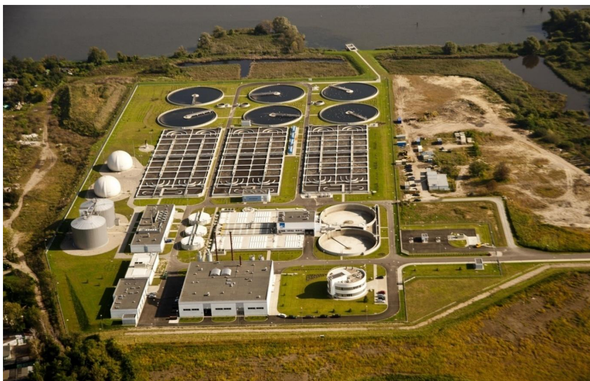
Fotografia IV.1.3. Oczyszczalnia ścieków Pomorzany (źródło: ZWIK, WIOŚ Szczecin)
