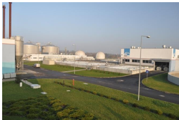
Fotografia IV.1.2. Oczyszczalnia ścieków Pomorzany (źródło: ZWIK, WIOŚ Szczecin)
